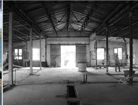
Laboratorios Integrados, Edificio G. Hudson (interior, antes y después)
