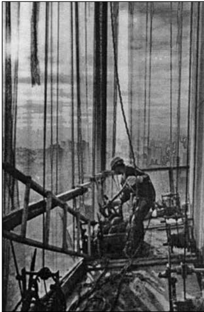
Trabajo de albañil, San Pablo, 1996
